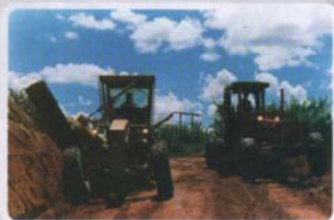
Máquinas em ação na manutenção das estradas rurais.
