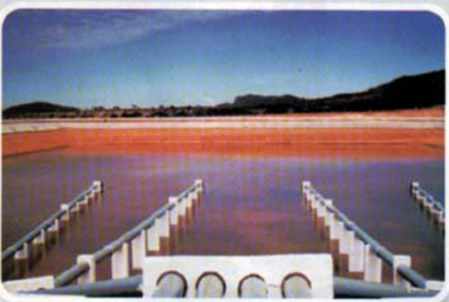
Estação de Tratamento de Esgoto - ETE, Construída com recursos cedido pela SEPLAN
