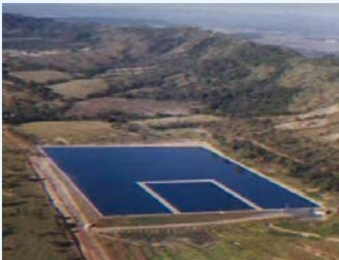
ETE - Estação de Tratamento de Esgoto
